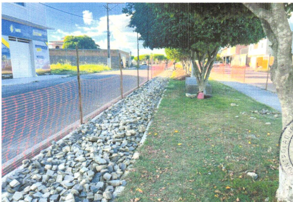
FOTO 08 – REMOÇÃO DE PEDRA PORTUGUESA
