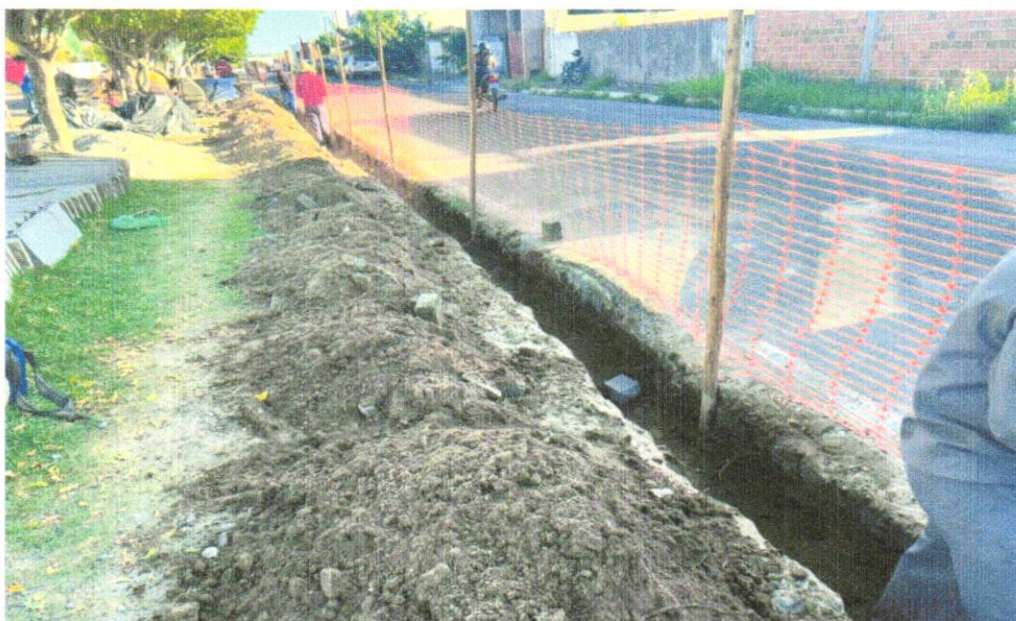
FOTO 01 – ESCAVAÇÃO MANUAL DE VALA COM PROFUNDIDADE MENOR OU IGUAL A 1,30 M
