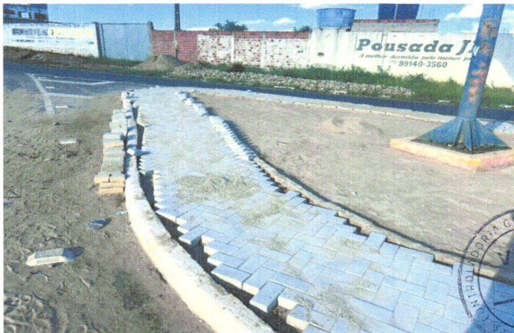
FOTO 06 – Pavimentação em bloco de concreto vibroprensado, intertravado, cor natural, 10x20cm, e=6cm, 46un/m 2 , NBR9781, Fck(min)=35MPa, sob coxim areia grossa compactada c/ placa vibratória, e(comp.)=6cm, rejuntado c/ areia fina
