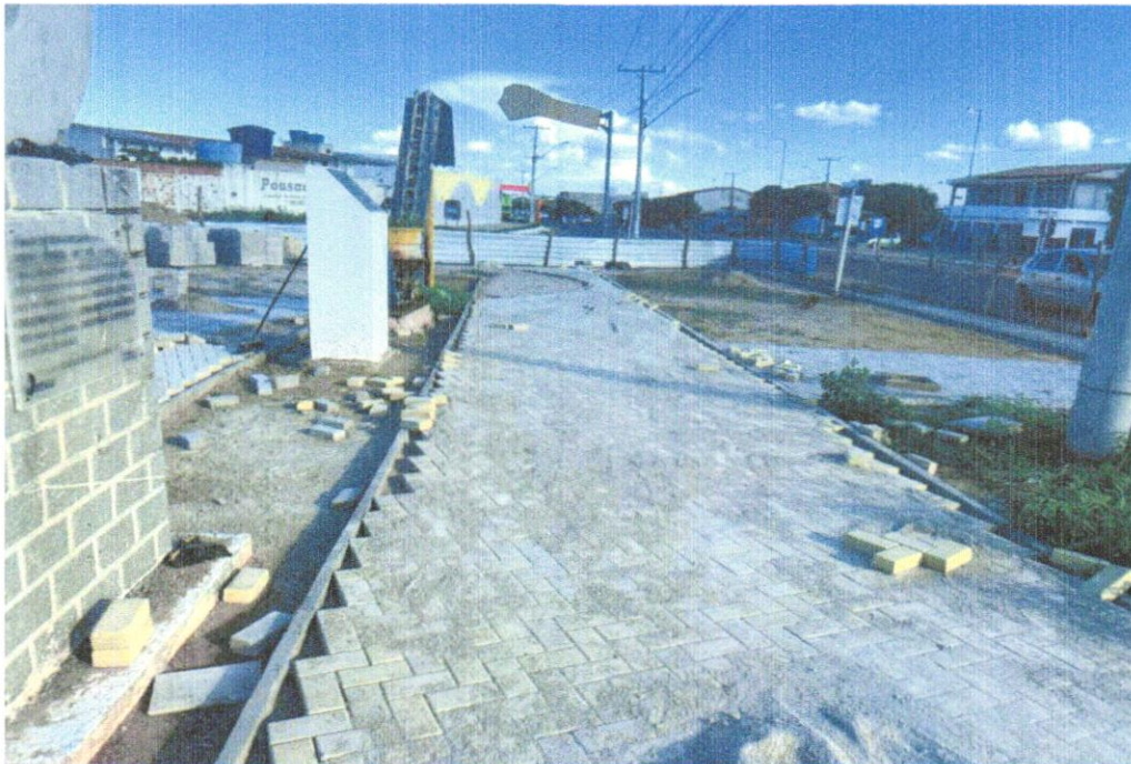
FOTO 07 – Pavimentação em bloco de concreto vibroprensado, intertravado, colorido, 10x20cm, e=6cm, 46un/m 2 , NBR9781, Fck(min)=35MPa, sob coxim areia grossa compactada c/ placa vibratória, e(comp.)=6cm, rejuntado c/ areia fina
