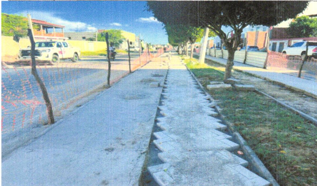
FOTO 03 - PAVIMENTAÇÃO EM CONCRETO, COM ESPESSURA DE 7 CM, COM ACABAMENTO FEITO UTILIZANDO ALISADORA DE CONCRETO (HELICOPTERO), INCLUIDO TELA DE AÇO SOLDADA NERVURADA CA60, Q196 (3,11 KG/M 2 ), DIAMETRO DO FIO 5.0 MM, LARGURA = 2,45 M, ESPAÇAMENTO DA MALHA = 10 X 10 CM, JUNTA DE DILATAÇÃO EM PVC A CADA 2,00 M, CONCRETO FCK = 20 MPA
